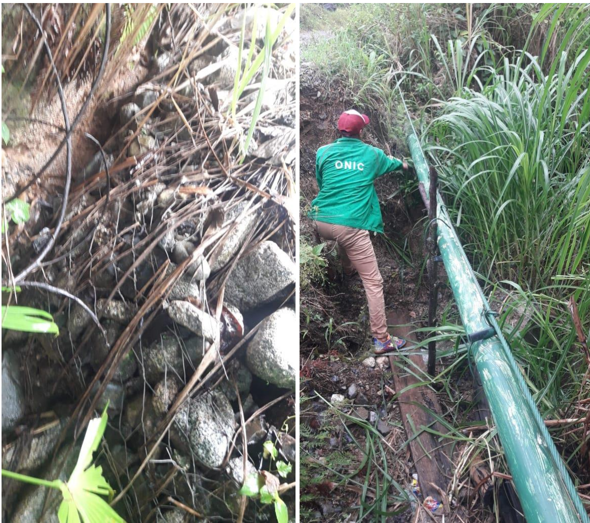
Registro fotográfico de muro de gavión construido en la vereda Mi chorrito.
